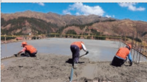
Vaciados de losa de piso de concreto armado
