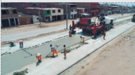
Mejoramiento de veredas
